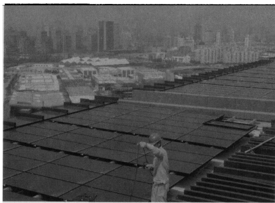
图 5 中国馆中的太阳能组件安装施工
